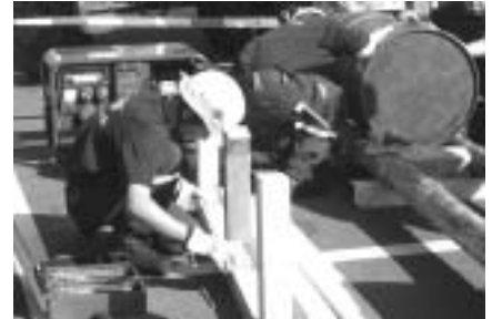
Errichtung eines Tonnenstegs
